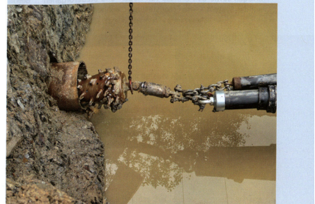
BILD 3: Einzug des Rohrbündels von der Startgrube
